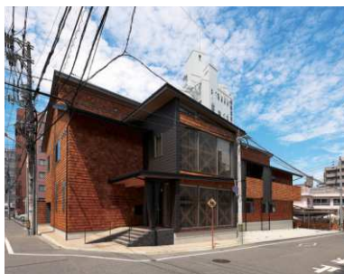
外観には遮炎性が高い天然木パネル「ウイルウォール」を採用
