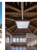
トップライトから放射状に広がる木組みが印象的な乳児棟
