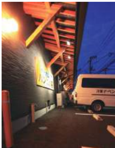
1.5mはね出した軒裏はあらかわし仕上げにし、力強さを表現
