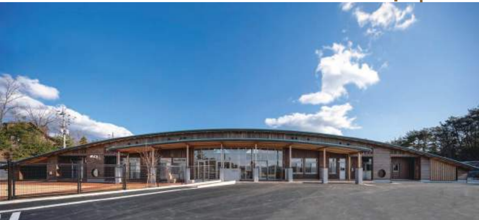
保育所全体を優しく覆う緩やかな曲線の大屋根が美しい。外壁は下見横板張りにヒノキ、縁押え縦板張りにはスギを採用
