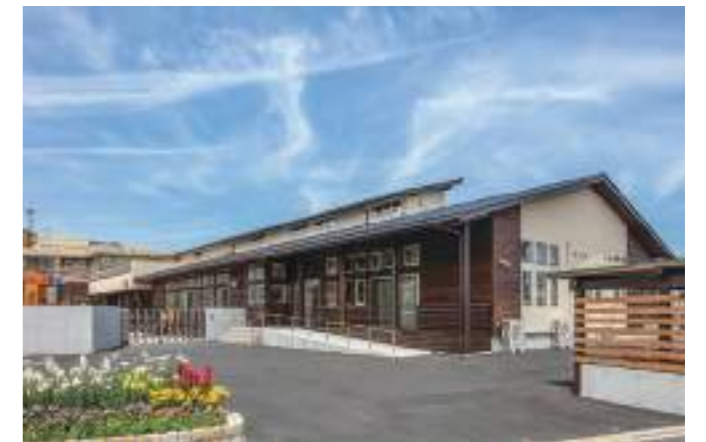
外壁に杉板を横張りし、昔ながらの木造校舎を想起させる外観
