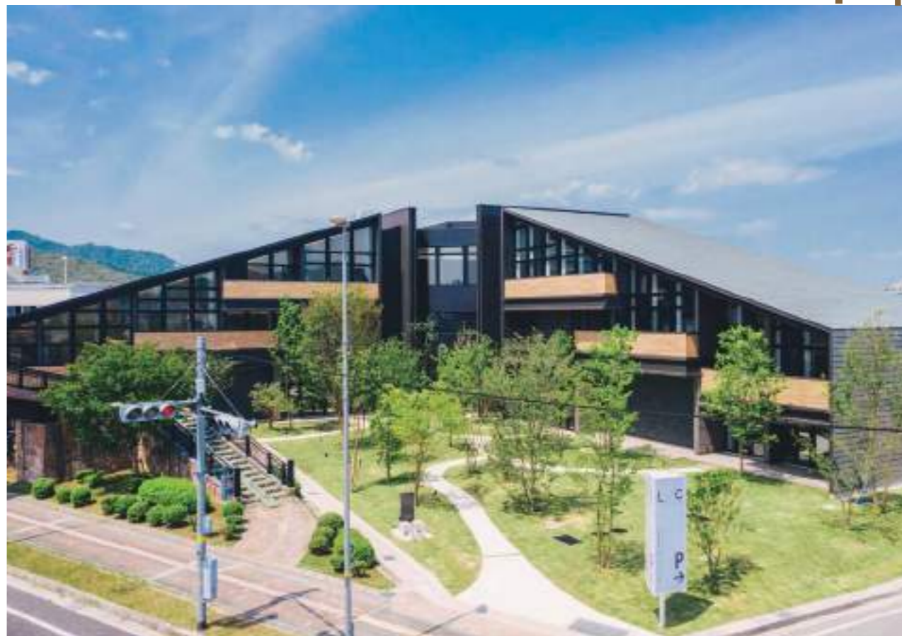
勾配のある建物をL字型に設計し、植栽を多く配置した中庭を囲む形が目を引く外観
