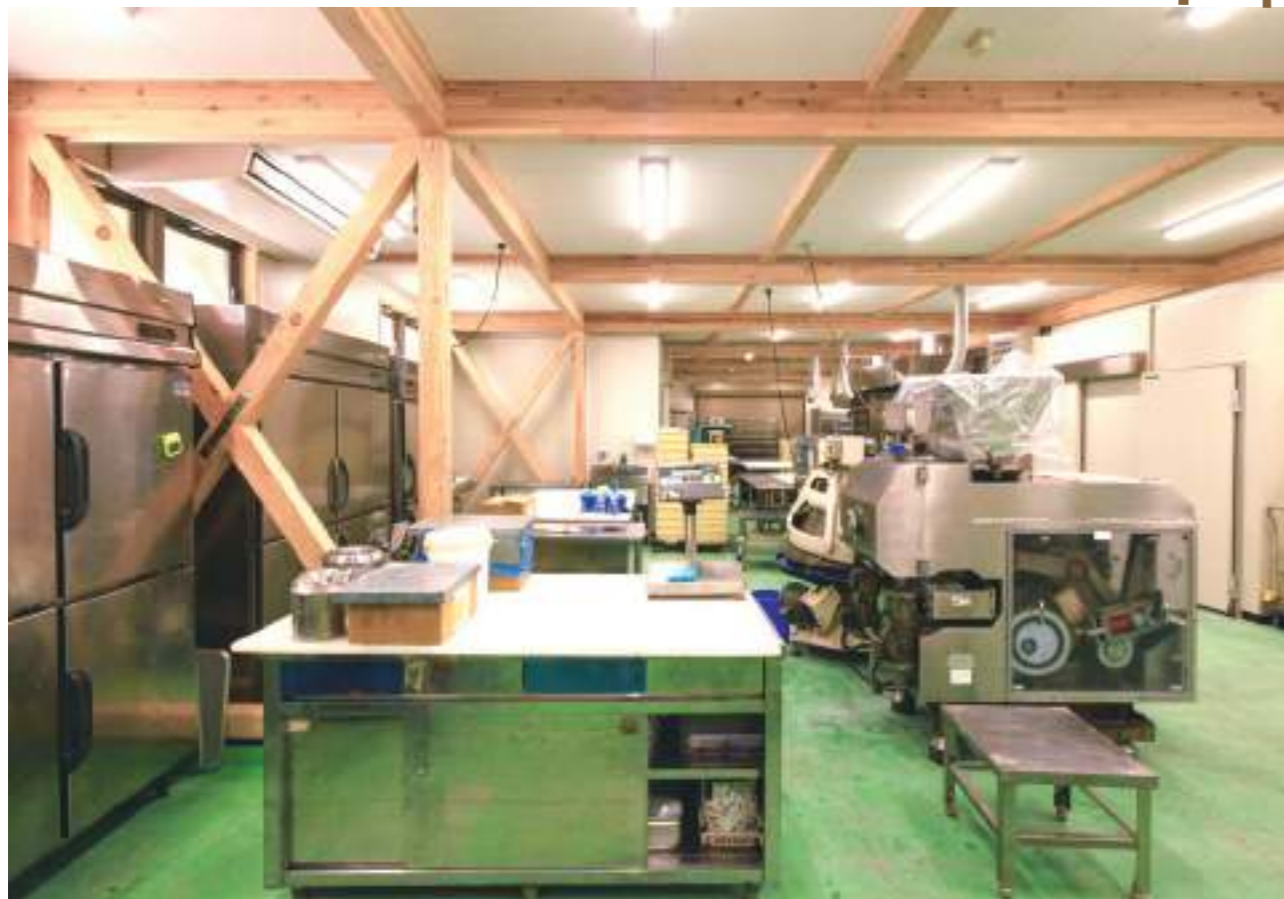
厳格な食品衛生法の制限がある中で、コストを抑えながらの木造軸組みと化粧仕上げを実現
