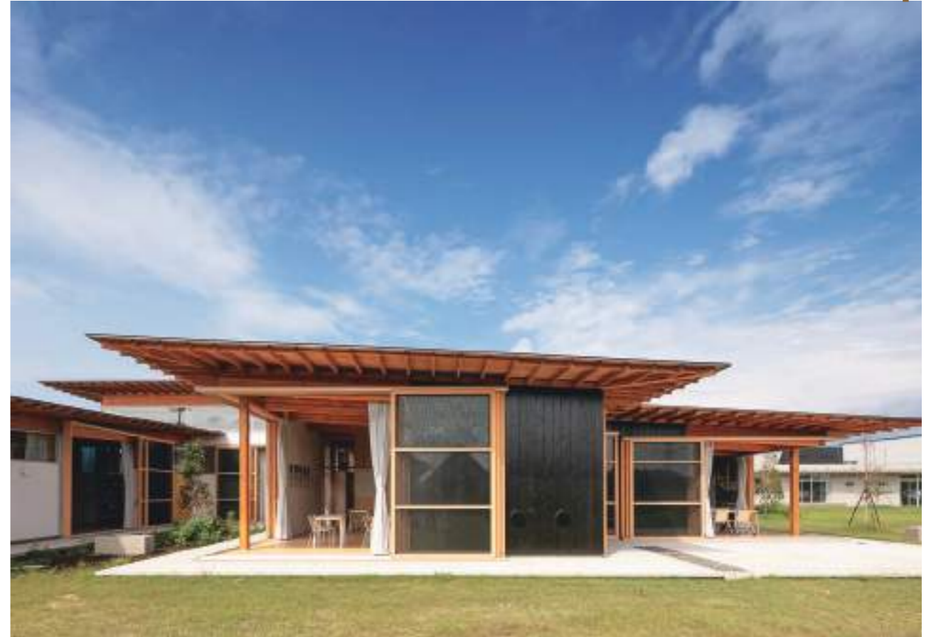
開放的な教室棟。大きな庇によって光や風を屋内に取り込み、自然を身近に感じられる環境が整う
