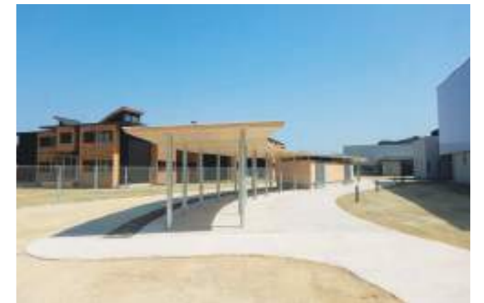
美しい曲線を描く駐輪場。一部渡り廊下にも屋根にスギCLTを採用
