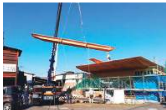
12m超の組立梁で施工し、工期短縮と大きな庇を実現
