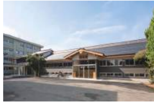
外壁の下部は鎧木目、上部は漆喰塗り調
