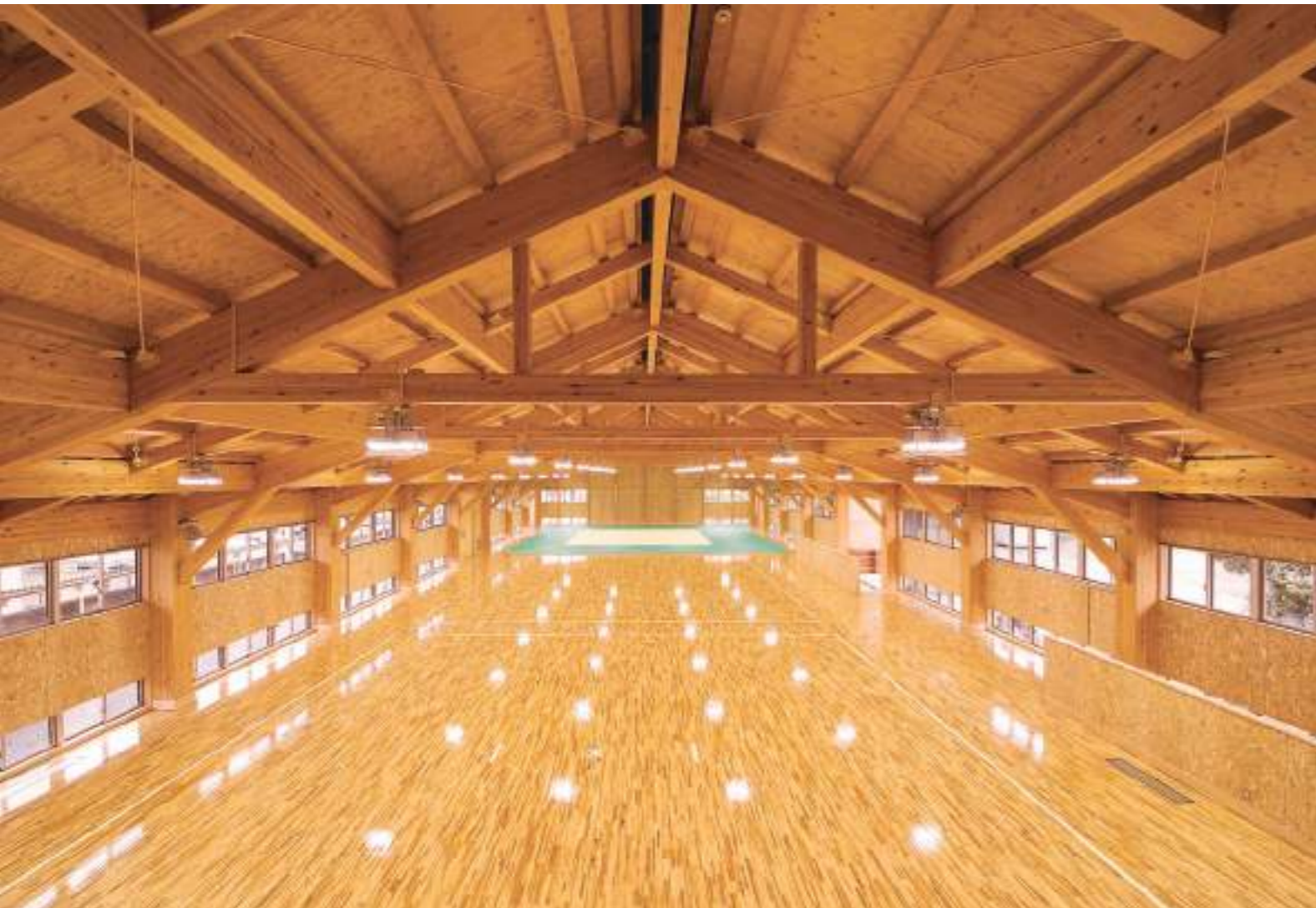
従来の天井上への断熱材敷き込みではなく、屋根に外断熱を施し、断熱効果向上や結露対策を実施した武道場「雄志館」内部
