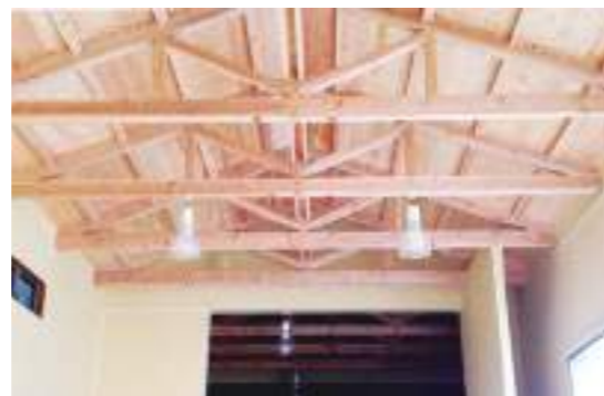
倉庫天井にも木造トラスが見える
