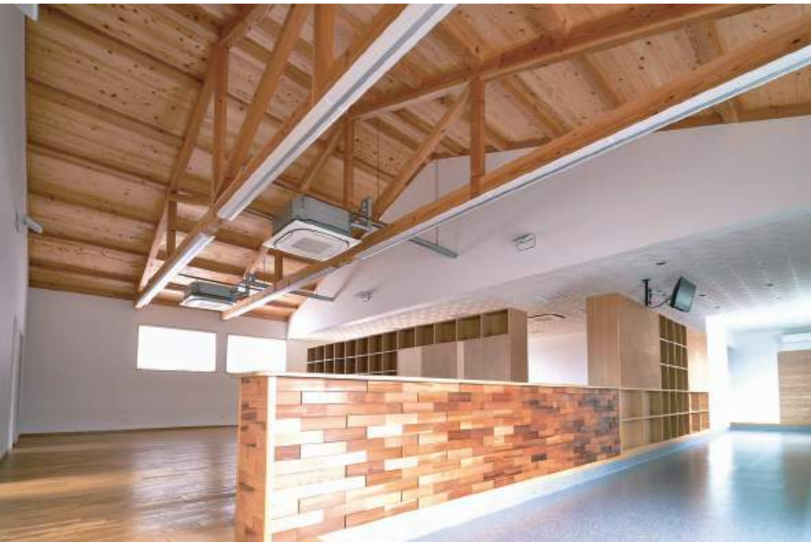
幅はぎ集成材を用いた事務所天井
