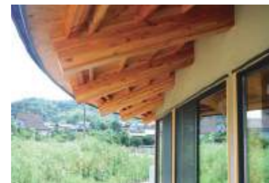
円形の外壁上に並ぶ登り梁
