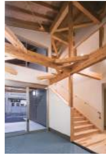
天井面は構造材が見られる
