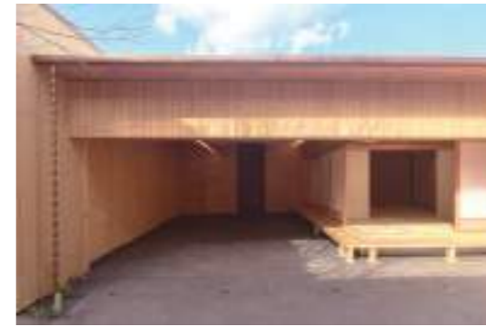
LVL厚板の壁が全体を囲む
