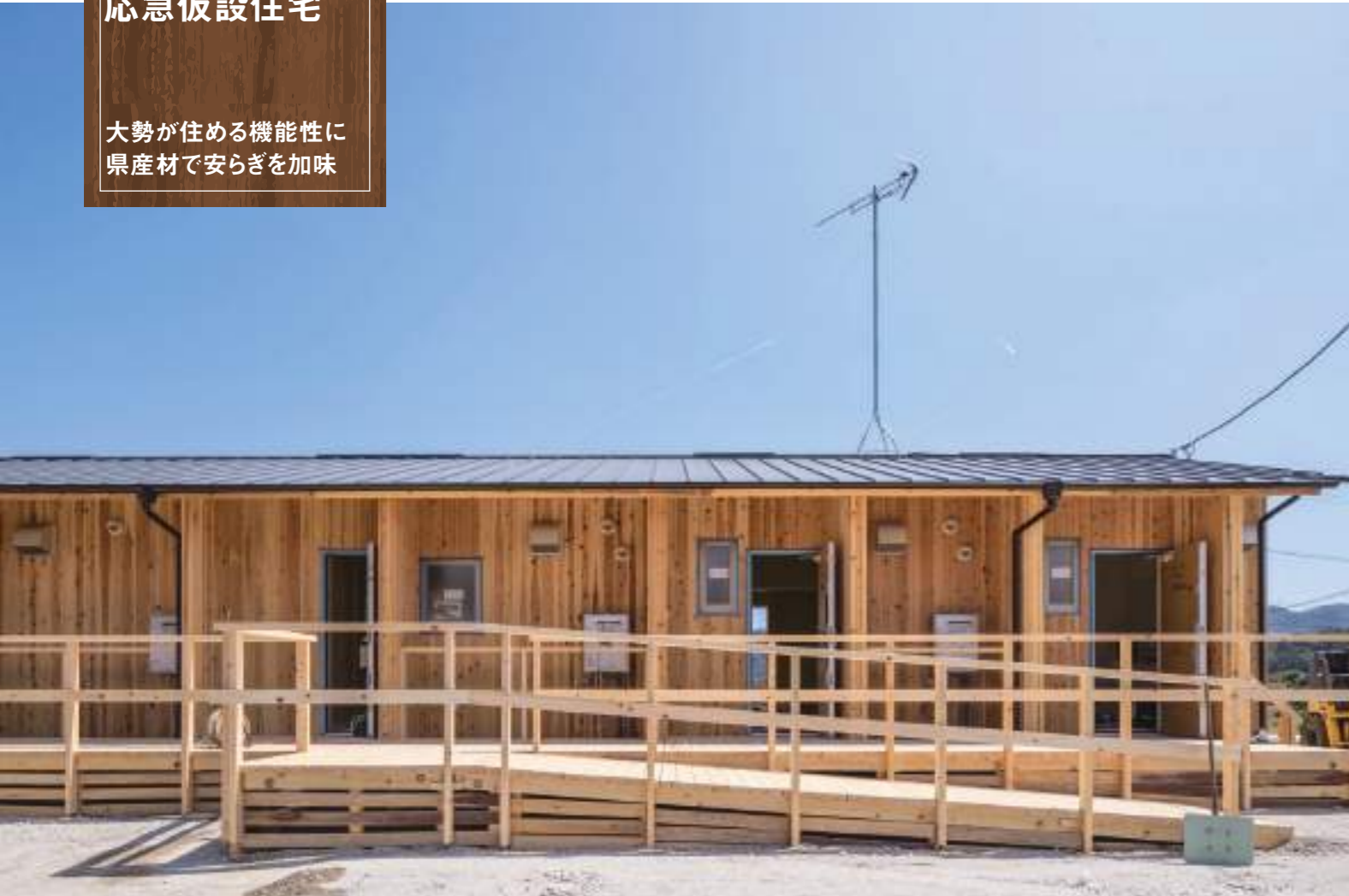
各戸の玄関とスロープ
