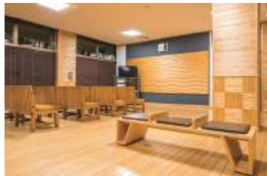
木調パネル張りの正面壁
